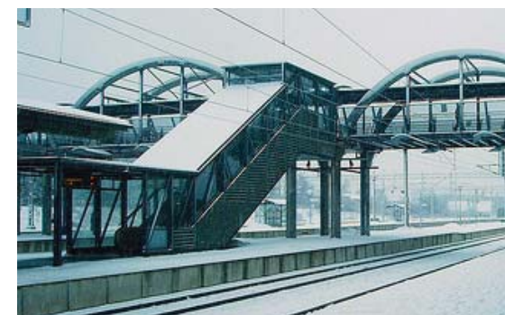
Väderskyddad gång- och cykelbro vid tågstopp (Lund)
