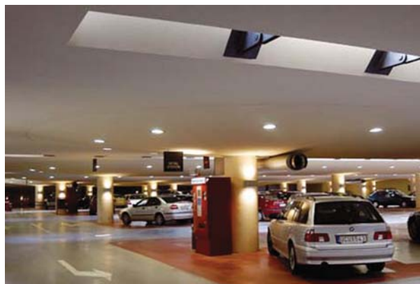
Ljust, vackert och tryggt parkeringsgarage (Helsingborg)
