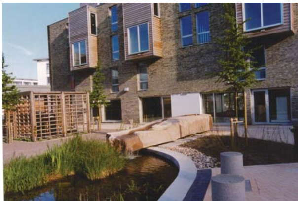
Dagvattendamm på den egna fastigheten.....
