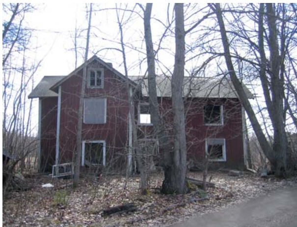
Rivning av förfallna hus kan ibland vara motiverat
