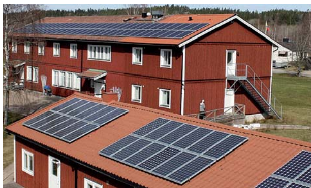
Solceller på tak
