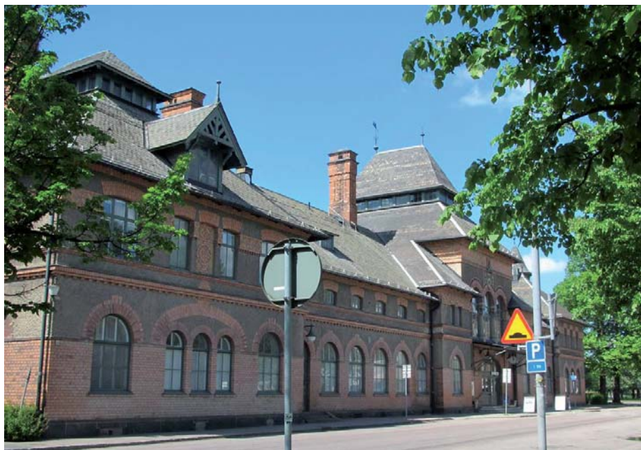
Krylbo järnvägsstation har byggnadsminnesstatus, i enlighet med kulturmiljölagen (1988:950)
