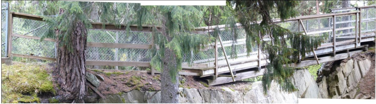
Figur 3. Östra sektionen från nordost. Östra sektionens norra bärlina vilar på bergklack i öster.
