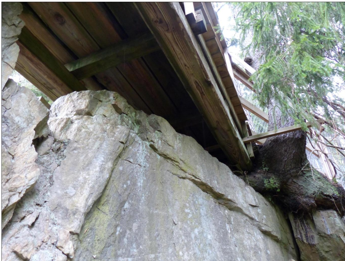
Figur 10. Östra sektionens östra fäste från sydväst. Den södra bärlinan vilar på en grov granrot. Granens rotsystem sträcker sig under hela östra brofästet.
