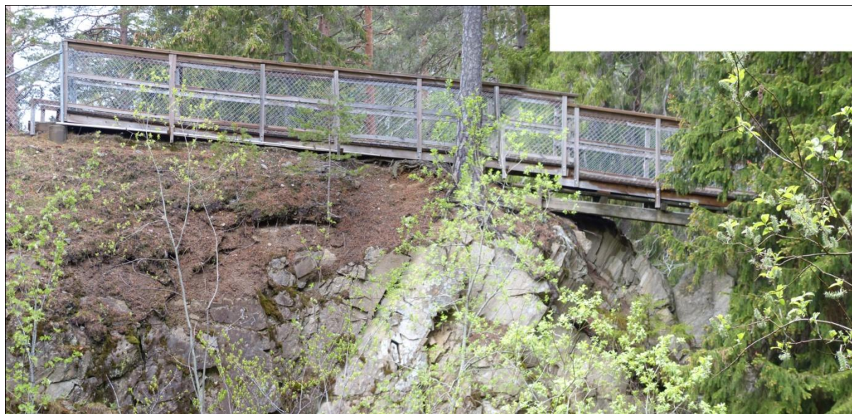
Figur 5. Västra sektionen från söder. Västra sektionens västra stödpunkt är på södra sidan fixerad i cementstolpe med ingjutet vinkeljärn (=staketstolpe) av stål. Hela södra sidan av träkonstruktionen vilar på lösa jordlager. Västra sektionens östra ände vilar dels på rotsystemet till en grov tall och dels på östra sektionens västra fäste, vilket i sin tur på södra sidan vilar på en bergklack (se figur 6 och 7).
