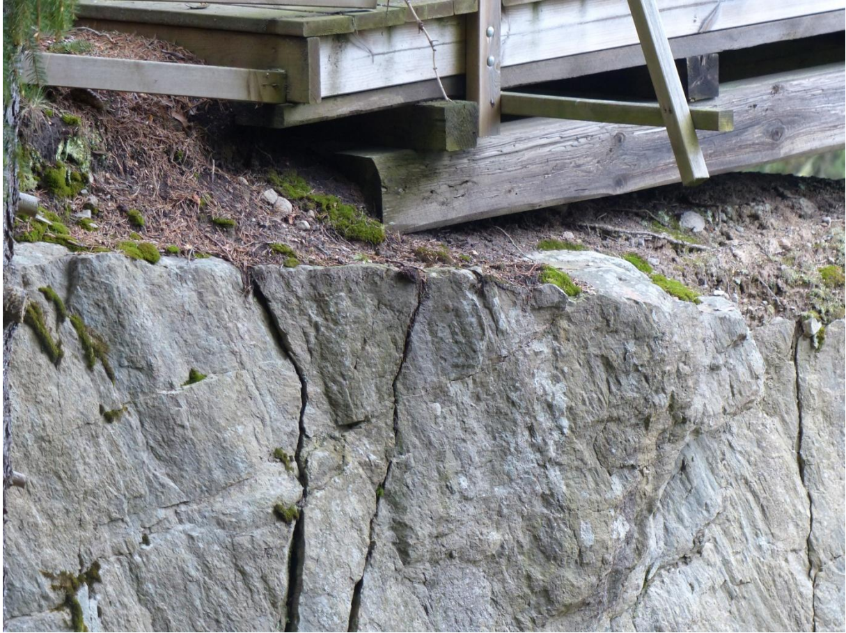
Figur 11. Östra sektionens östra fäste sett från norr. Östra sektionens norra bärlina vilar på en sprickig bergklack. Sprickorna bedöms i nuläget inte vara genomgående och kan om de utvecklas fixeras med bergbult. I skarven mellan östra sektionen och de lösa jordlagren på "östra anfarten" har jordlagren på norra sidan rasat ned och ett "snubbelhål" har bildats just intill uppsteget på bron (se även figur 16 och 17).
