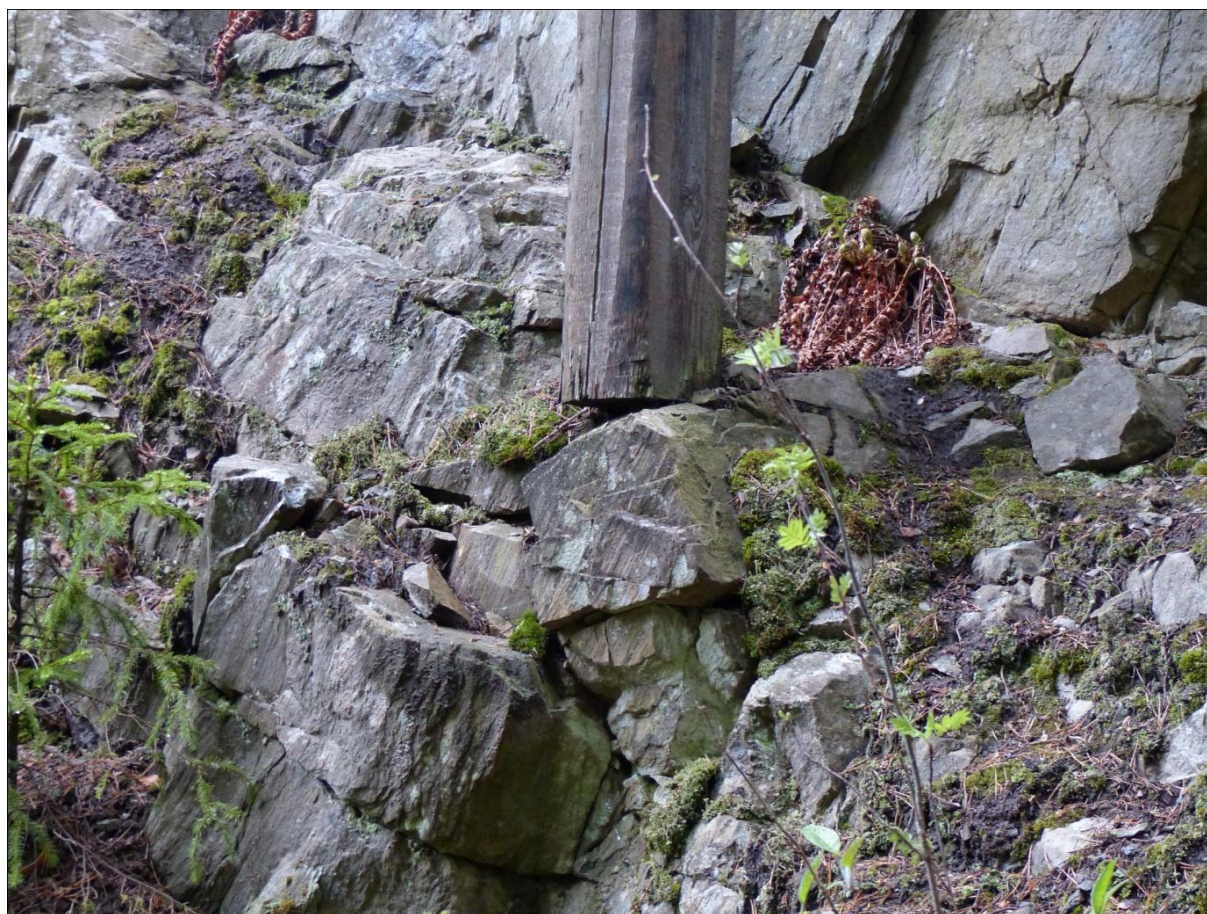
Figur 9. Östra sektionens södra bärlinas stödstolpe på södra sidan. Stödstolpen vilar löst och utan sidledes fixering på en sprucken bergklack/sten. Stolpen och stenen kan relativt enkelt fixeras genom att gjuta en klack och fixera stolpen med en bult.
