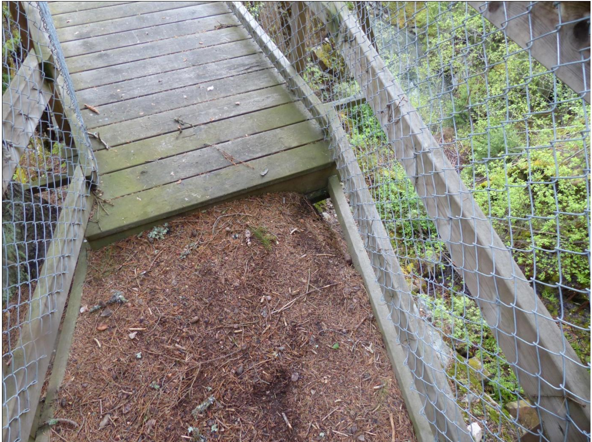
Figur 17. Östra landfästet med "snubbelhål".
