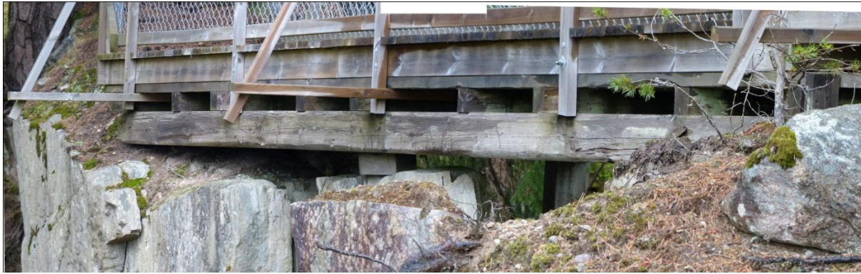
Figur 15. Östra sektionens norra sida sett från nordväst. Östra sektionens norra grova bärlina har stöd mot bergklackar i såväl öst som väst (figur 6 och 7) samt på halva spännvidden av tråkloss mot en bergklack.
