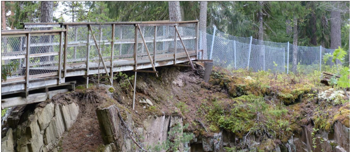
Figur 4. Västra sektionen från nordost. Västra sektionen vilar på östra sektionen och förbinds via ett kort trappsteg (fig 8). Västra sektionen är byggd av regelvirke som ursprungligen vilat på lösa jordlager samt är i väster fixerat i två ursprungligen vertikala cementplintar i lösa jordlager (figur 14). Observera vridningen i västra sektionens träkonstruktion där de lösa jordlagren rasat ned mot norr och tagit bort stödet för konstruktionen (se även bild 12, 13)
