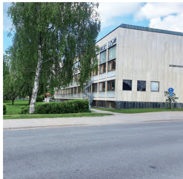
Söder om kommunhuset saknas passage/övergångsställe. WSP 2022.
